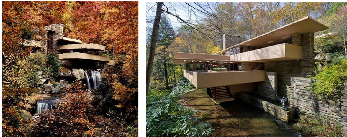
Ilustración 19 Vistas de la Casa de la Cascada
