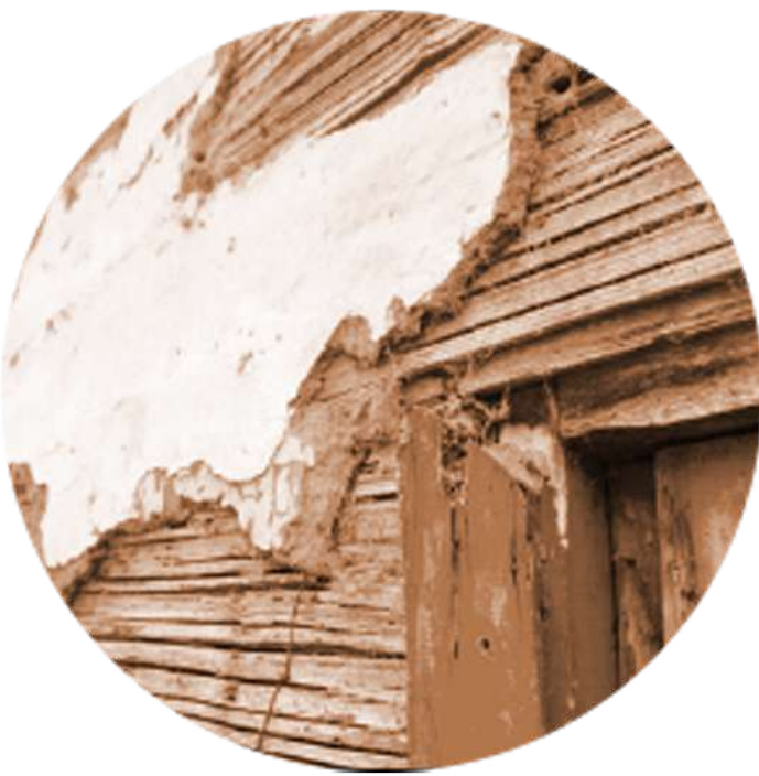
Construcciones en bahareque
