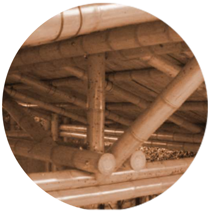
Estructura en guadua
