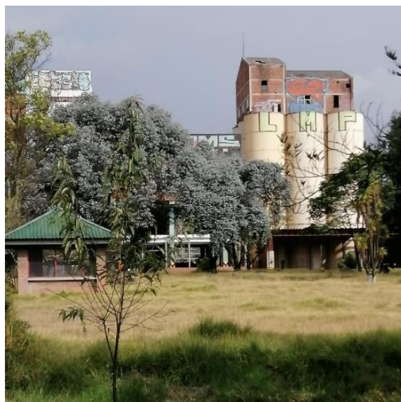
Figura 9: edificio de la fabrica bavaria, Bogotá 2020. Fuente: Elaboración del autor (2020).
