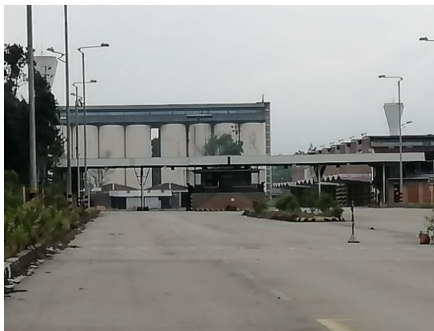
Figura 6: silos de la fabrica bavaria, Bogotá 2020. Fuente: Elaboración del autor (2020).
