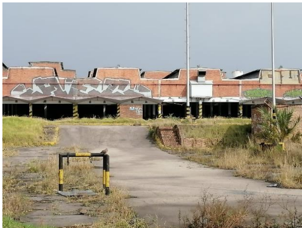
Figura 7: edificio de la fabrica bavaria, Bogotá 2020. Fuente: Elaboración del autor (2020).
