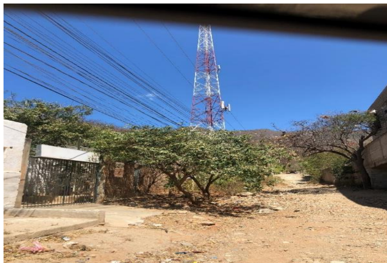
Figura 1. Fotografía del deterioro de Taganga.
