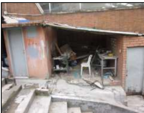
Fuente: Autor – área calderas
