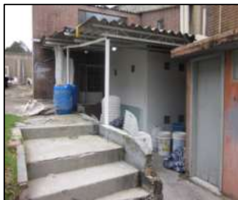
Fuente: Autor – área calderas
