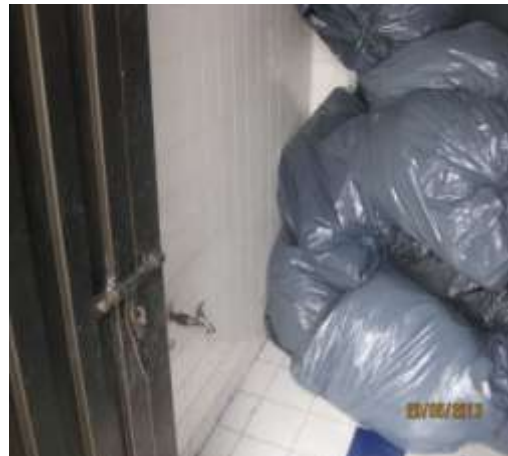
Fuente: Autor – Shut basura parqueadero principal
