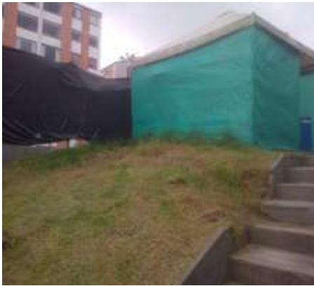
Fuente: Autor – área atrás calderas y piscina
