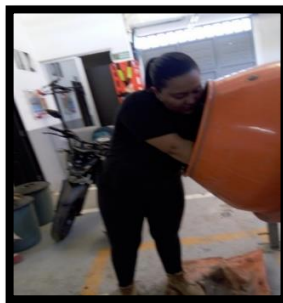
Figura 12. Preparación del concreto
