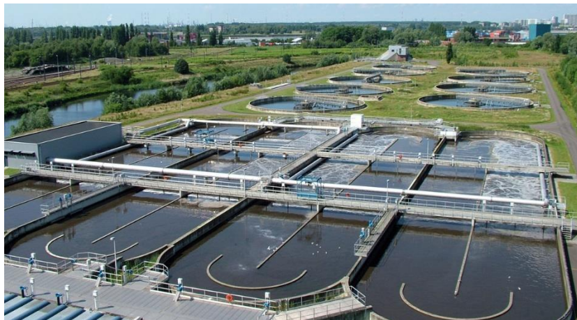
FIGURA 1. Planta de tratamiento de aguas residuales, fotografía recuperada de (CICI, 2017) (DIEGO RODRIGUEZ, 2019)
