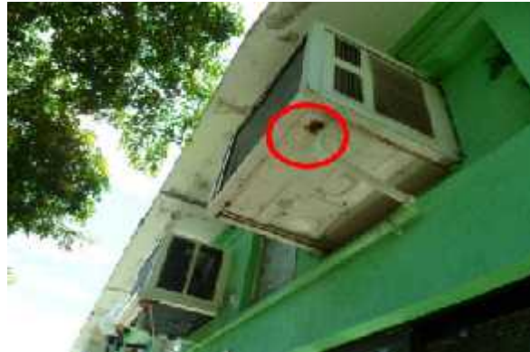
Figura 60. Adecuacion de las unidades de aire acondicionado.
