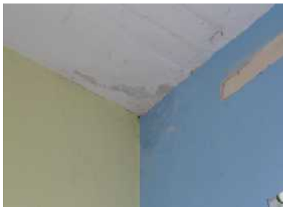
Figura 18. Vista placa segundo piso.
