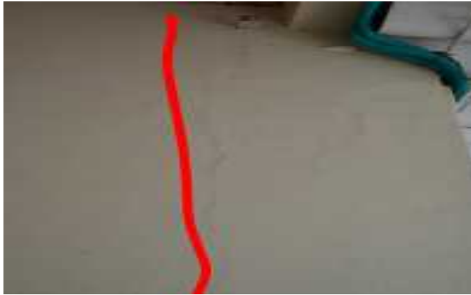
Figura 58. Vista de la dilatación de la columna.
