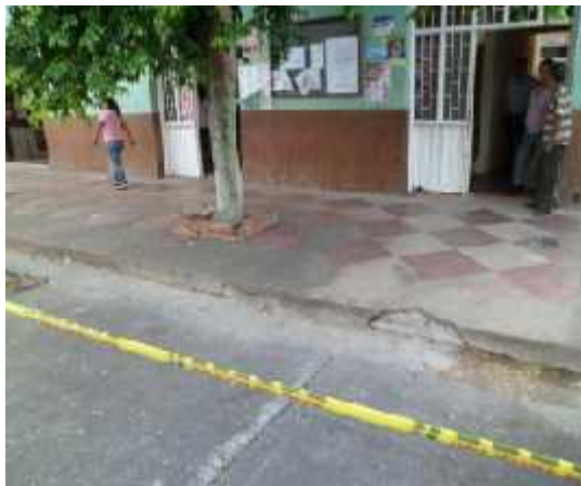
Figura 24. Vista anden entrada principal.
