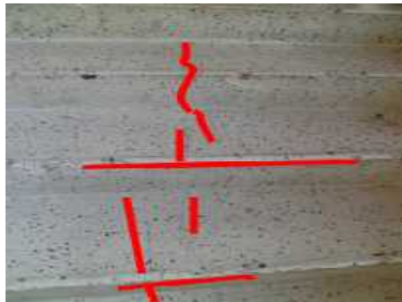
Figura 35. Vista acabados escaleras.
