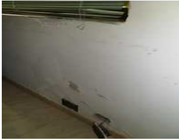
Figura 21. Vista interior muros segundo piso.
