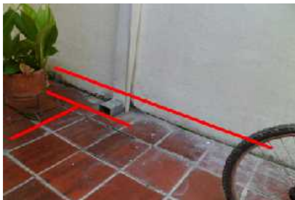
Figura 22. Vista piso y contrapiso.
