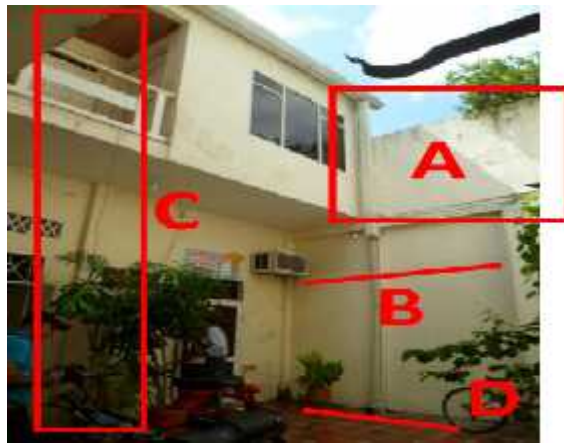
Figura 45. Muros internos del patio.
