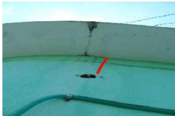
Figura 59. Vista placa alero cubierta.
