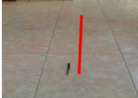
Figura 25. Vista piso pasillo.
