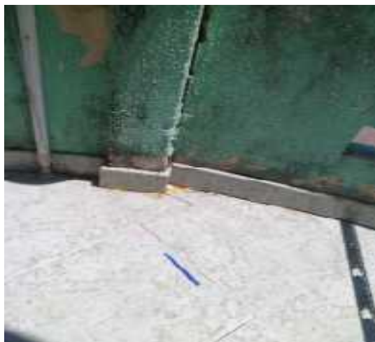
Figura 26. Vista parcial balcón.
