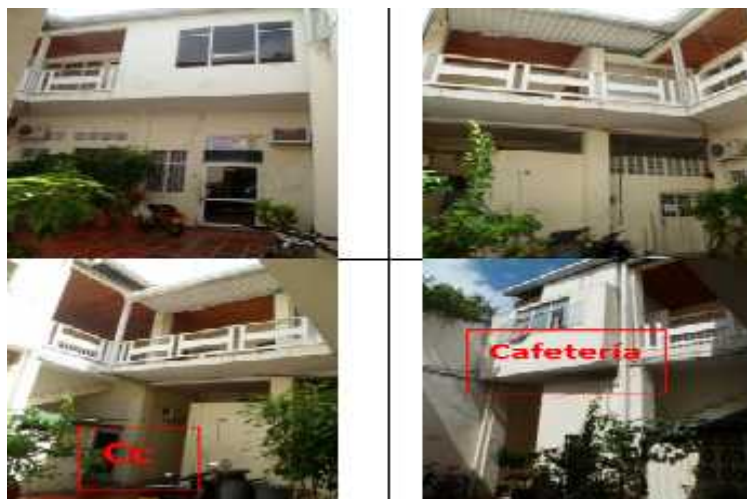
Figura 43. Vista de las dos plantas en la parte interior.
