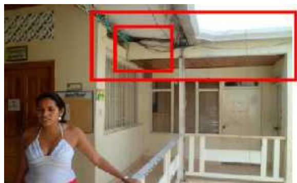
Figura 54. Union de las dos edificaciones.
