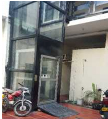
Figura 61. Ascensor de acceso.
