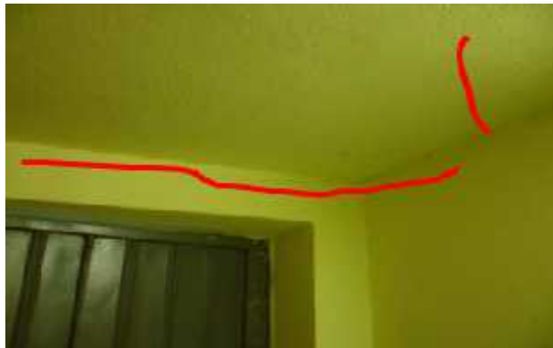
Figura 52. Placa pasillo Oficina de Planeacion.
