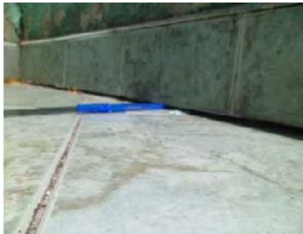
Figura 28. Vista parcial piso balcón.
