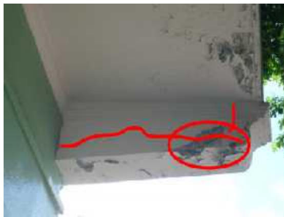
Figura 31. Vigas de soporte.
