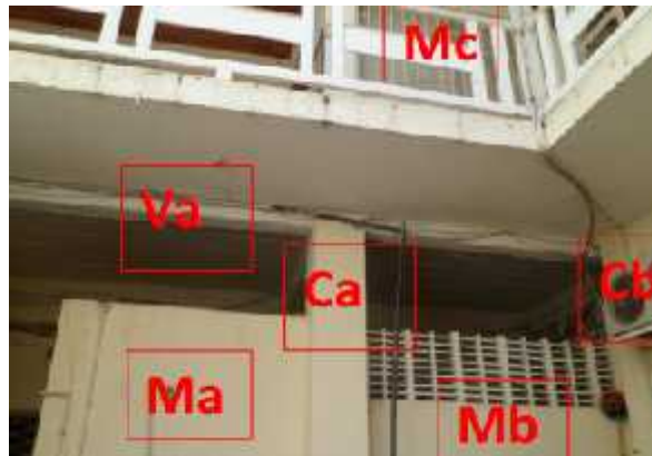
Figura 42. Vista del patio.
