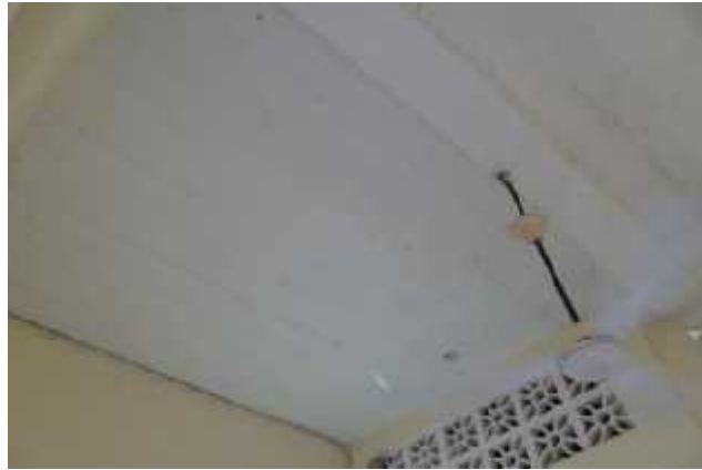
Figura 37. Vista construcción de vigas.
