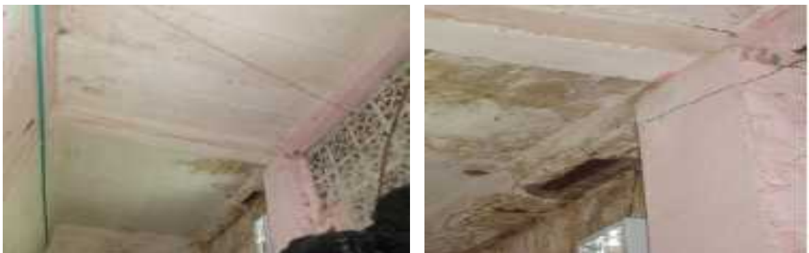
Figura 49. Placa de entrepiso.
