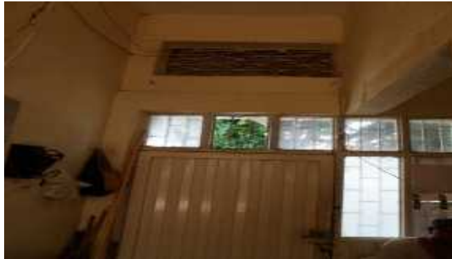
Figura 40. Placa de entrepiso.
