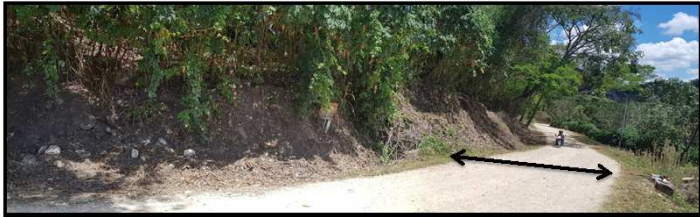
fotografia 1. Via alcantarilla vereda Apicata
