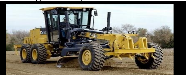
Imagen 11. Aireación de la subrasante cuando el material tiene exceso de humedad.
