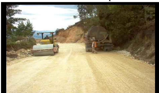
Imagen 16. Compactacion del material.
