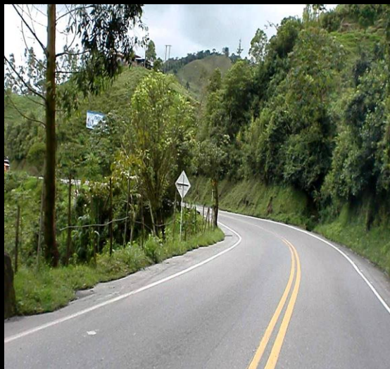
Imagen 3 y 4. Vías en pavimento flexible en Colombia.
