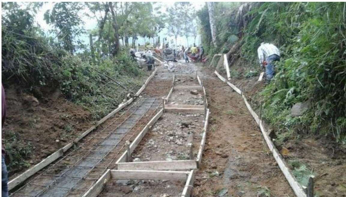
Figura 4. Placa huella en construcción.
