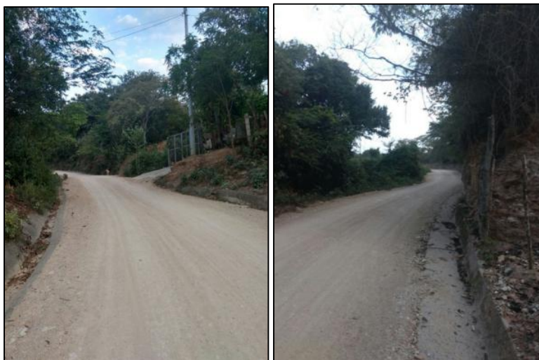
Figura 43. Vía con afirmado.
