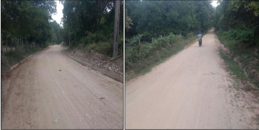
Figura 28. Vía existente con un afirmado de espesor variable.
