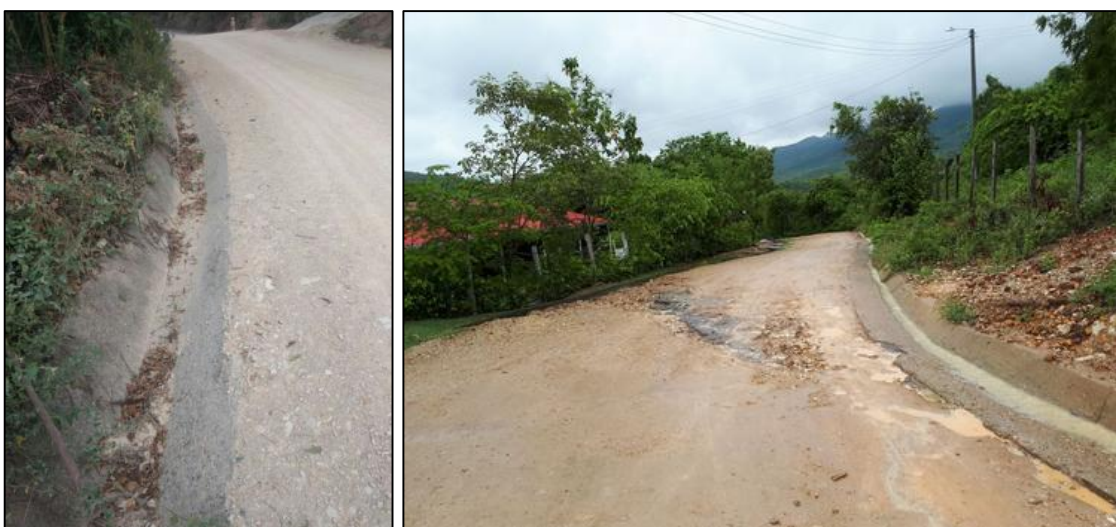
Figura 31. Cunetas existentes en la vía.
