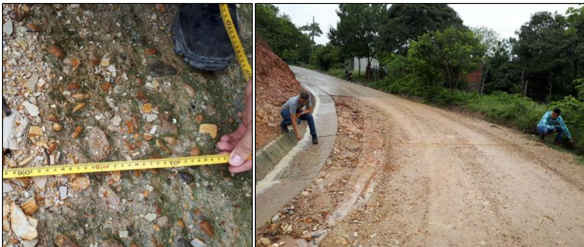
Figura 29. Verificación del ancho de vía.
