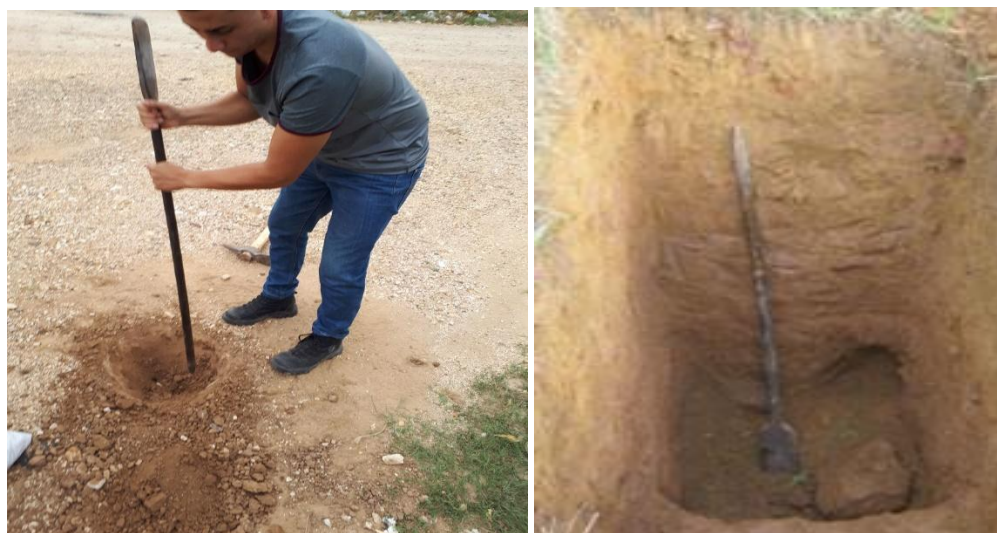
Figura 16. Excavación de los Apiques.
