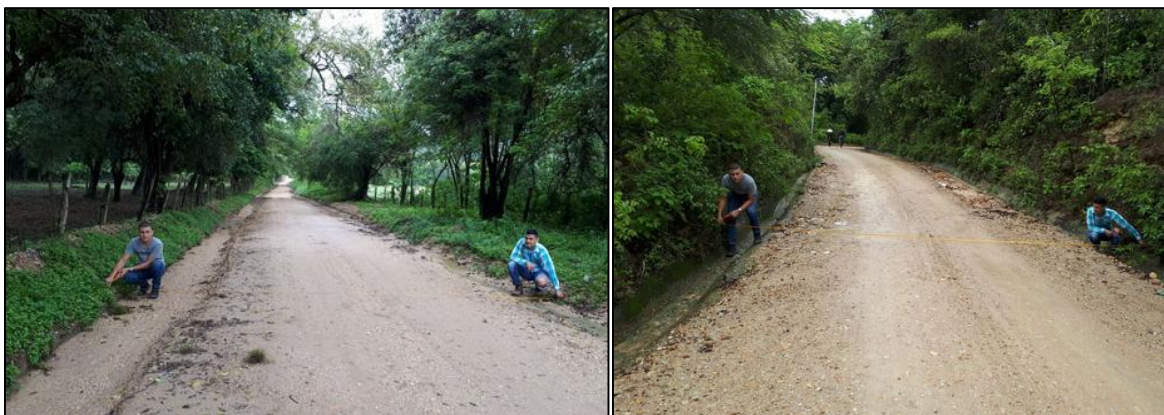
Figura 30. Vía existente con un ancho de vía de 6m.
