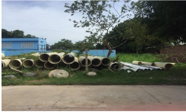
Figura 14 . Almacenamiento de tubería a la intemperie
