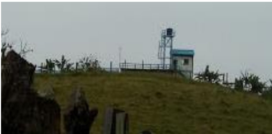
Imagen 6: Planta de Tratamiento de Agua Potable PTAP. Fuente: Propia
