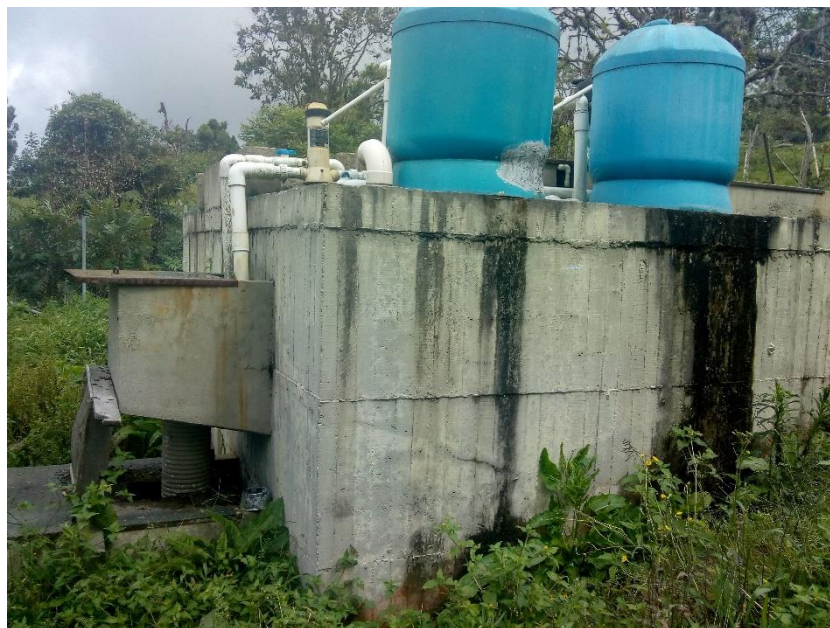
Imagen 9. Estado Actual de la PTAR La Victoria. Fuente: Propia.
