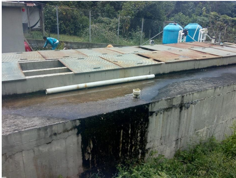
Imagen 12. Tanques de digestión y procesos de tratamiento. Fuente: Propia.
