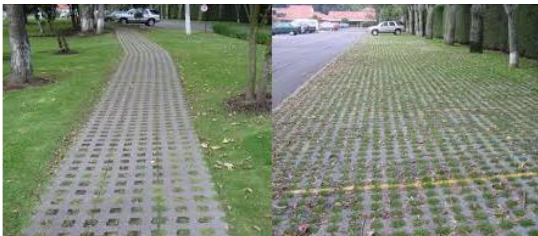
Figura 34. Ejemplos de senderos peatonales y parqueaderos en adoquín ecológico. Fuente: (Ecotelhado Colombia, 2013)
