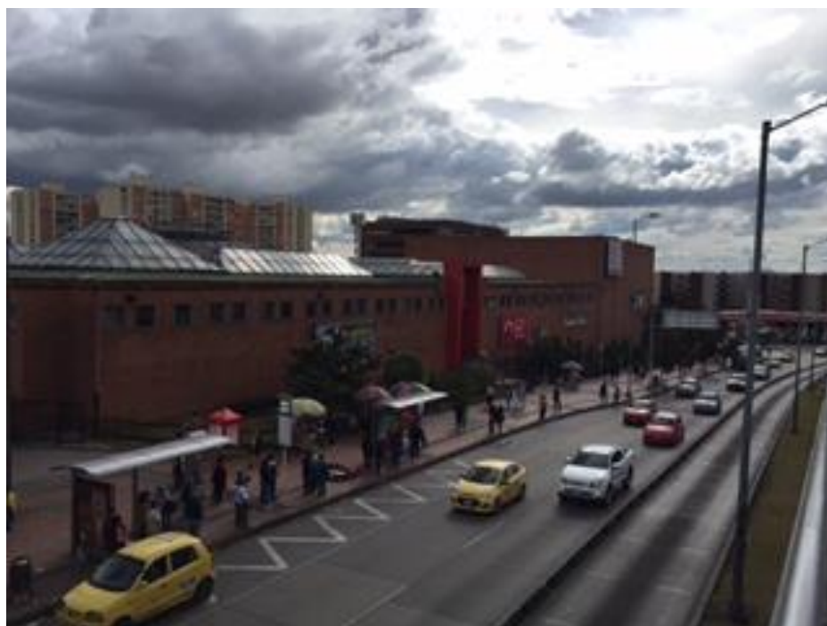
Figura 12. Edificio del centro comercial Centro Suba construido en ladrillo y cubiertas en metal y acrílico. Fuente: Fotografía tomada en sitio - Año 2015.
