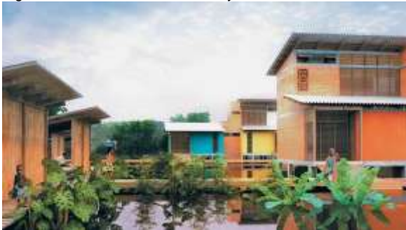
Figura 24. Lavaderos comunales y viviendas con diferentes crecimientos.
