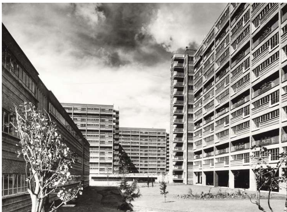
Figura 7. Espacio interior del CUPA
