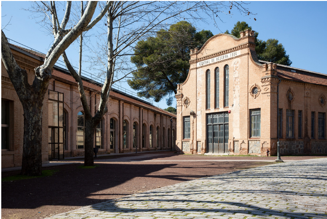
Figura 4. Edificio Central de Reserva en Campus Tecnológico de la UCLM, en Fábrica de Armas de Toledo, 1999-2010 Fuente: fotografía de David Utrilla.
