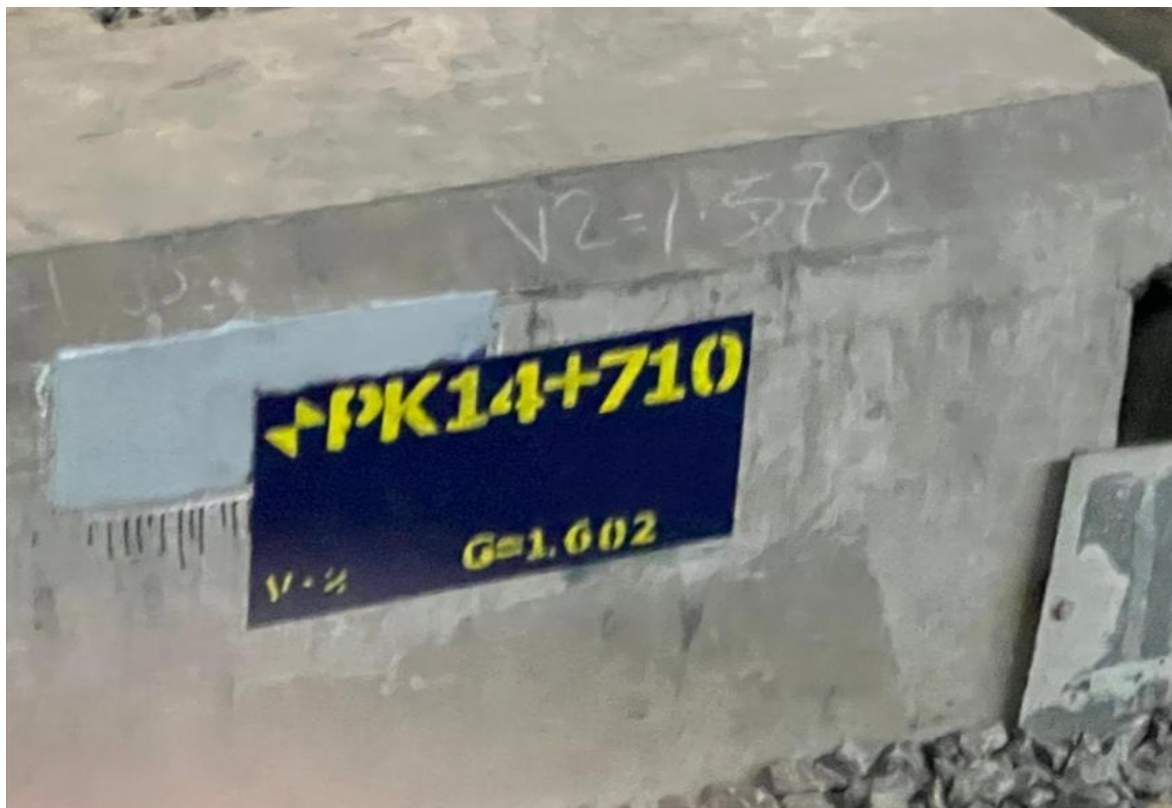
Fotografía N° 10 Espitia, J. (2025). [Línea 12 del metro México D.F] [Fotografía original]. Archivo personal
