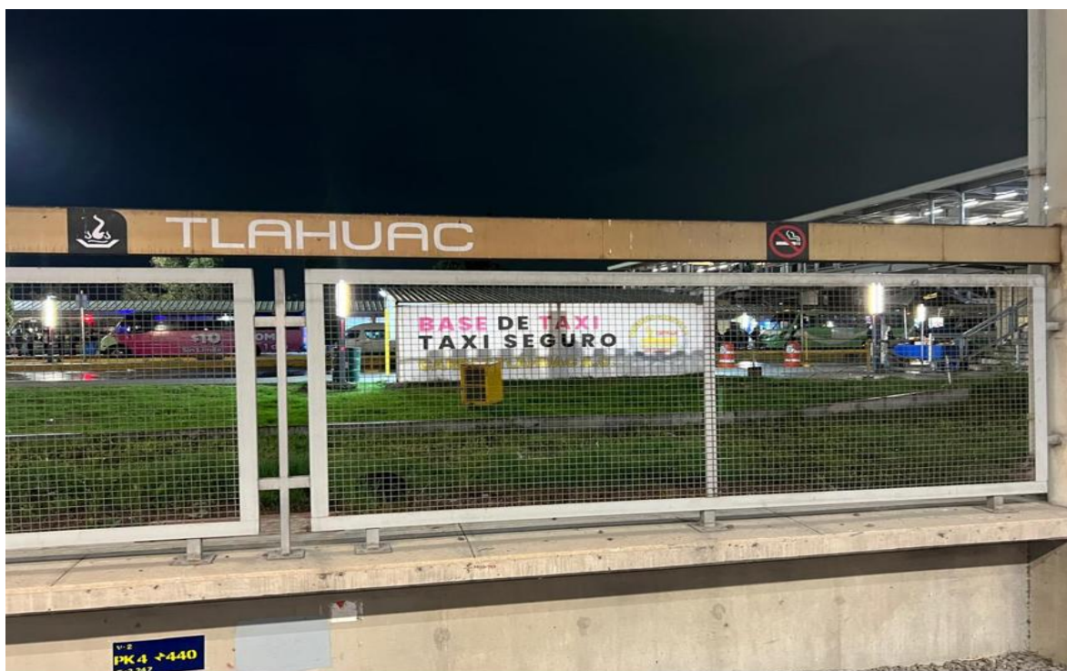
Fotografía N° 11 Velasco, J. (2025). [Línea 12 del metro México D.F Estación TLAHUAC] [Fotografía original]. Archivo personal
