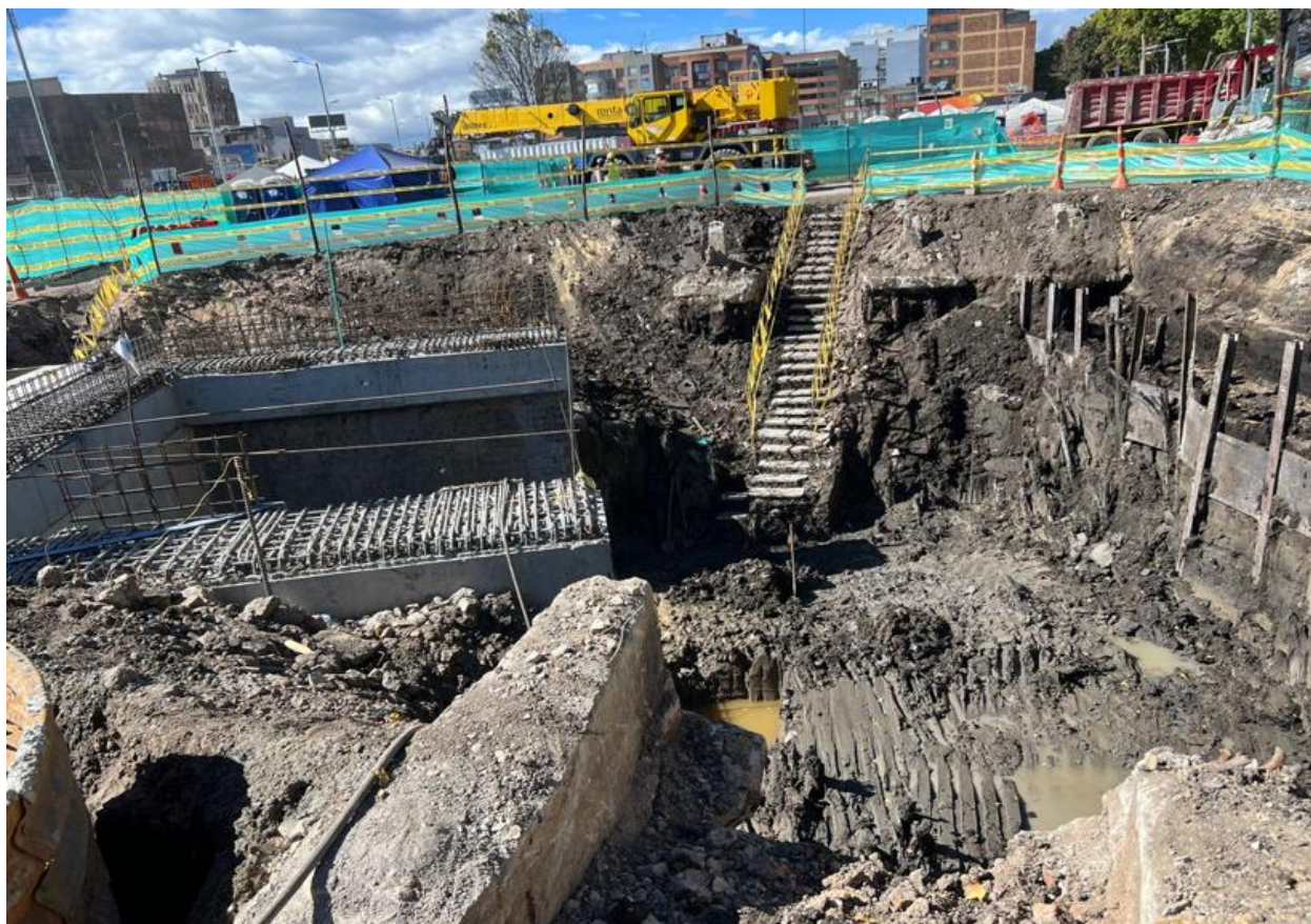
Fotografía N° 5 Velasco, J. (2025). [Línea 2 del metro Bogotá D.C] [Fotografía original]. Archivo personal.
