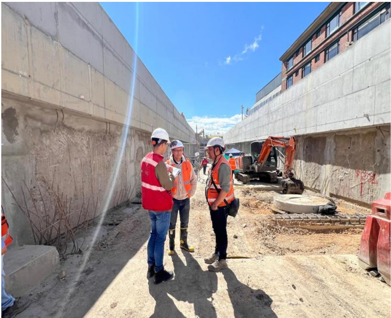
Fotografía N° 4 Velasco, J. (2025). [Línea 2 del metro Bogotá D.C] [Fotografía original]. Archivo personal.
