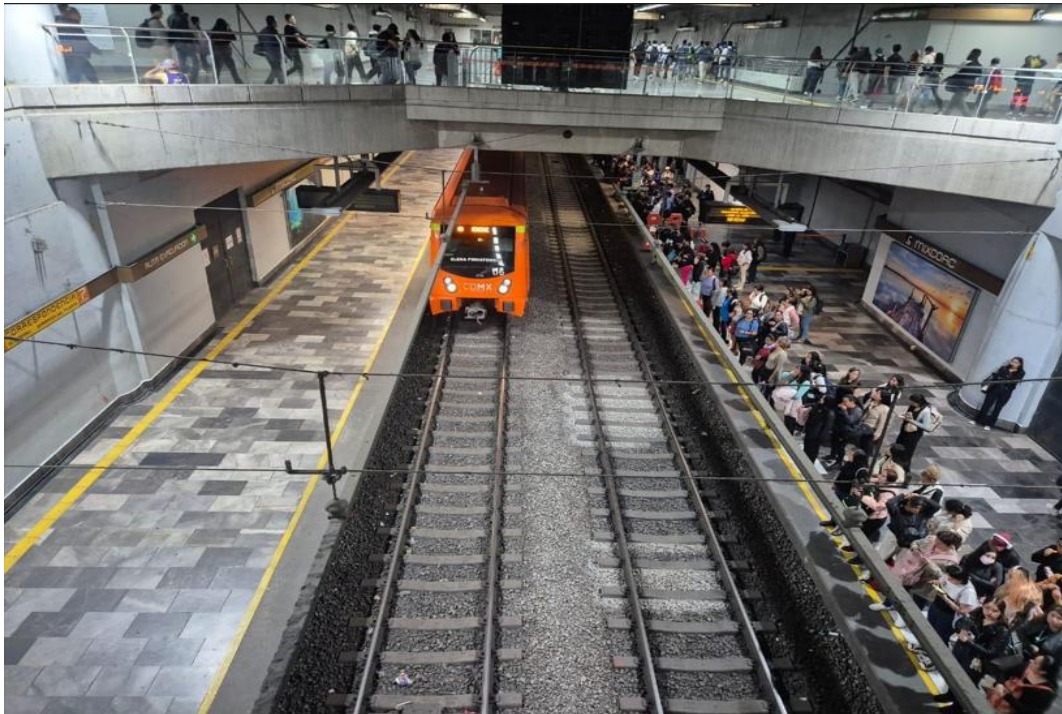
Fotografía N° 1 Velasco, J. (2025). [Línea 12 del metro México D.F] [Fotografía original]. Archivo personal.
