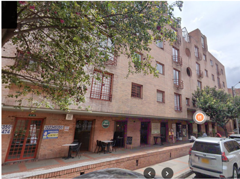
Figura 2. Conjunto residencial nueva Santa Fe
