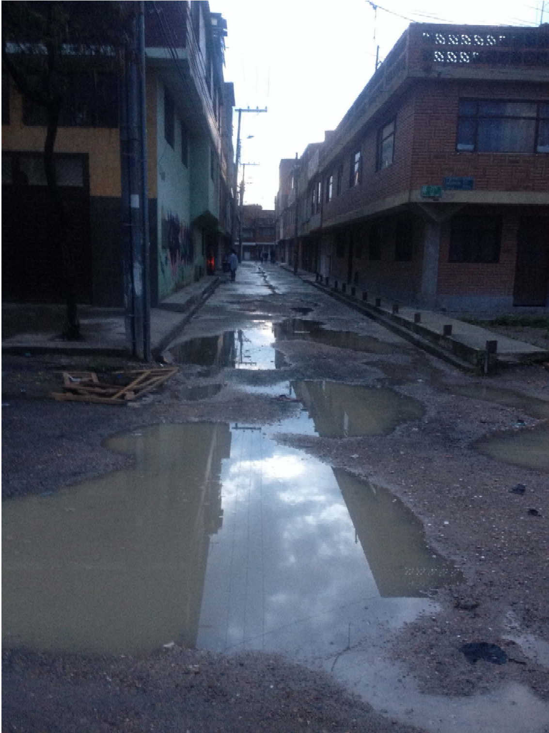
Ilustración 76. Intersección Avenida Villavicencio KR 71 B Calle 55 Bis Sur.
