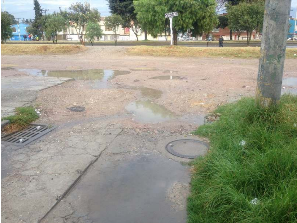
Ilustración 71. Intersección Avenida Villavicencio KR 71 B Calle 54 C Bis Sur.
