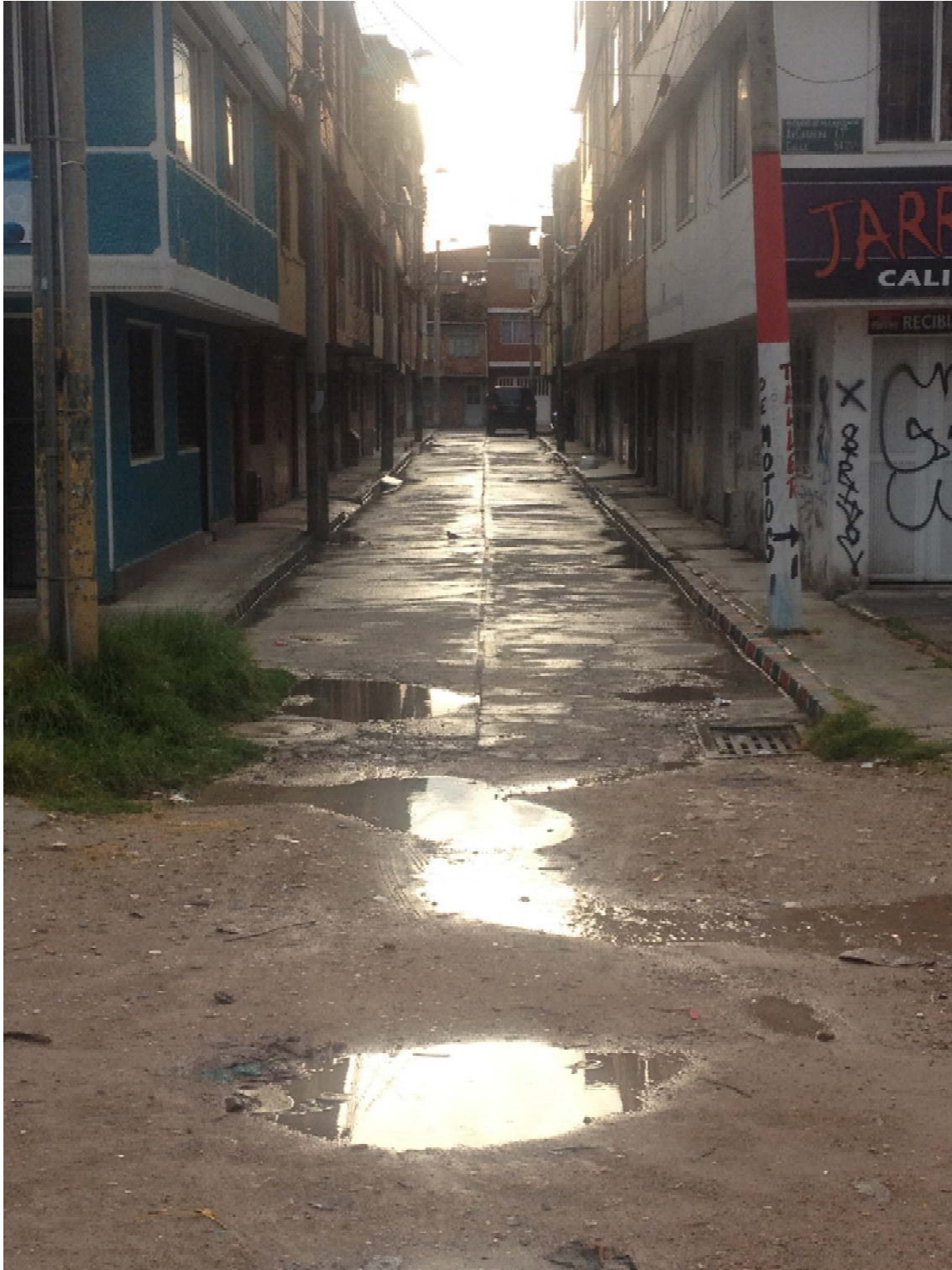
Ilustración 70. Intersección Avenida Villavicencio KR 71 B Calle 54 C Bis Sur.
