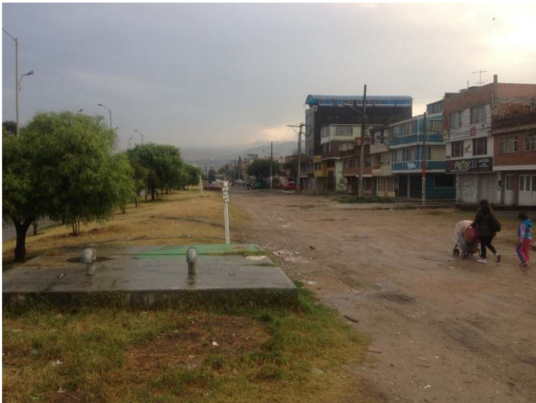
Ilustración 68. Cámara de acceso red de acueducto Línea Villavicencio 24"
