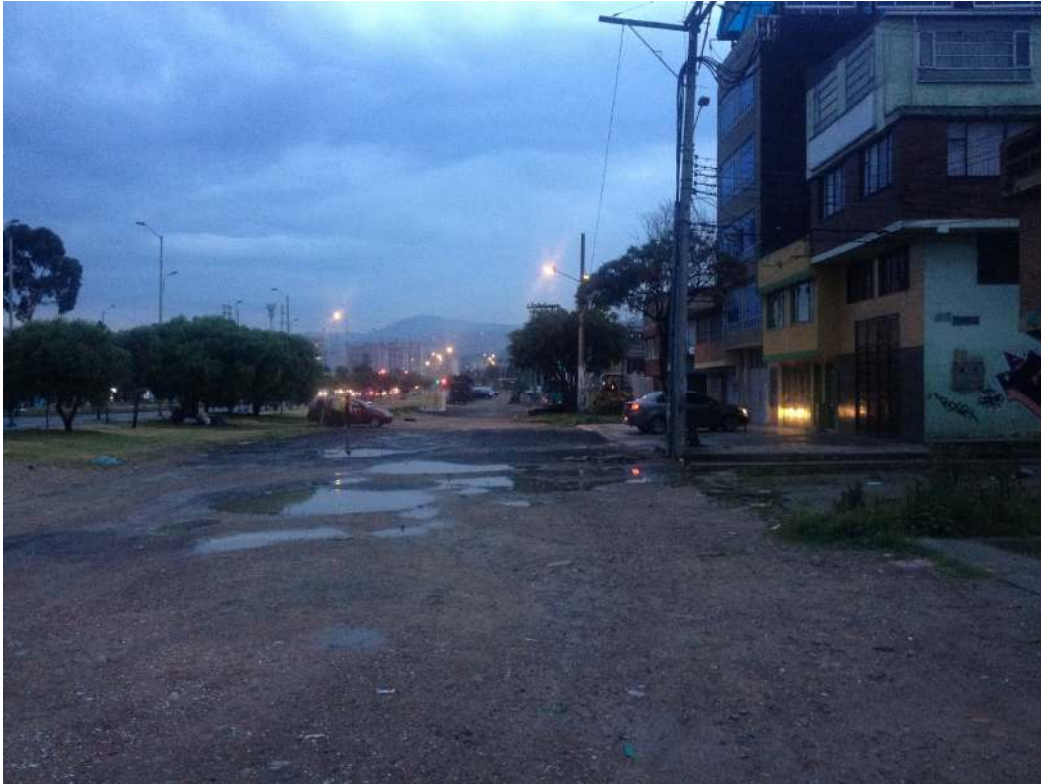
Ilustración 77. Intersección Avenida Villavicencio KR 71 B Calle 55 Bis Sur.
