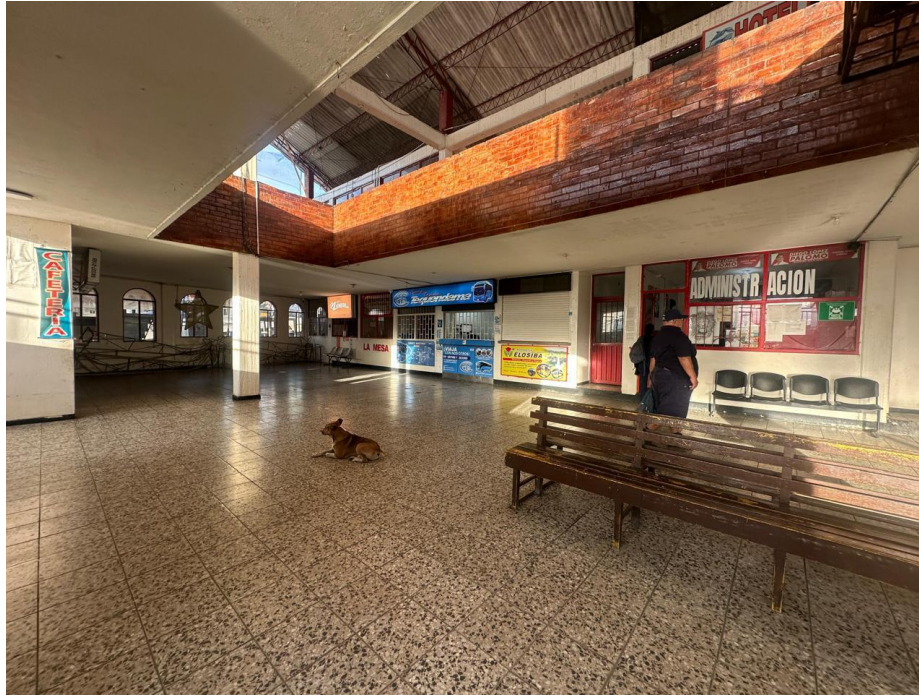
Imagen 2: Estado interno del terminal
