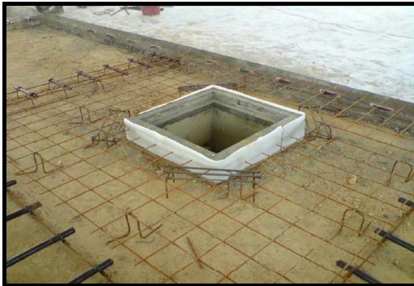
Ilustración numero 32 ilustración losa con elemento fijo
