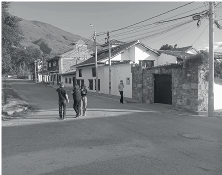
Tipología residencial urbana, fachadas continuas con muros blancos y portones de madera.
