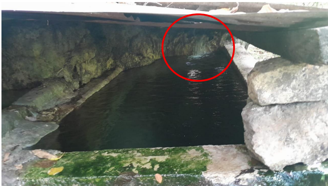
Ilustración 14 Tanque de 2,90m x 1,60m - caída de agua del afloramiento del punto 2
