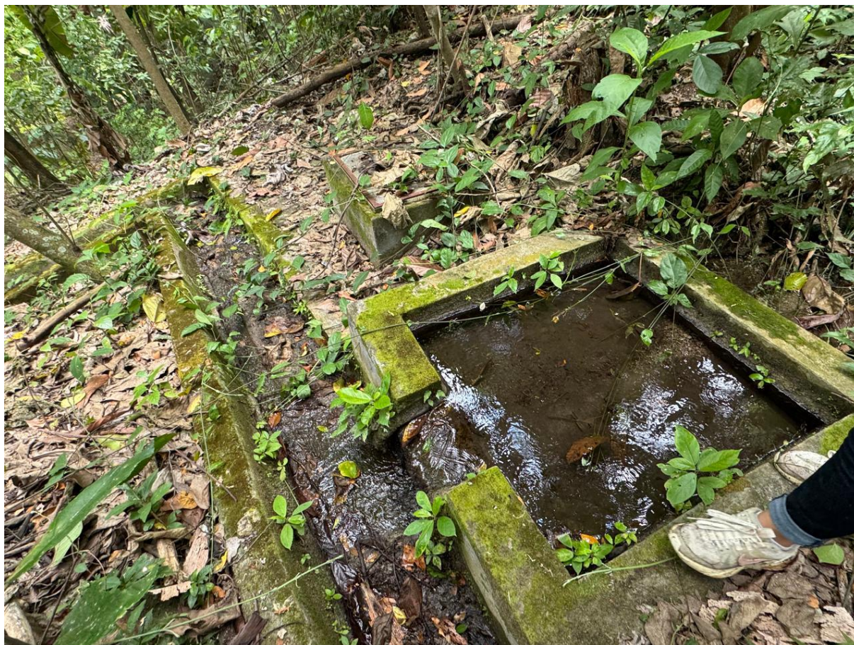
Ilustración 21 Sistema de captación existente
