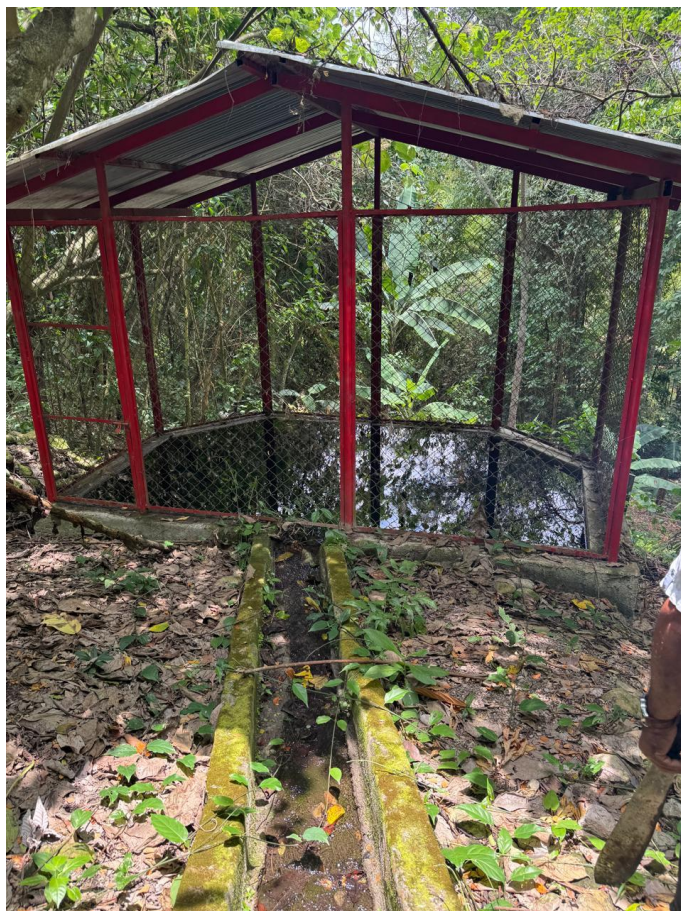
Ilustración 22 Sistema de Desarenador existente
