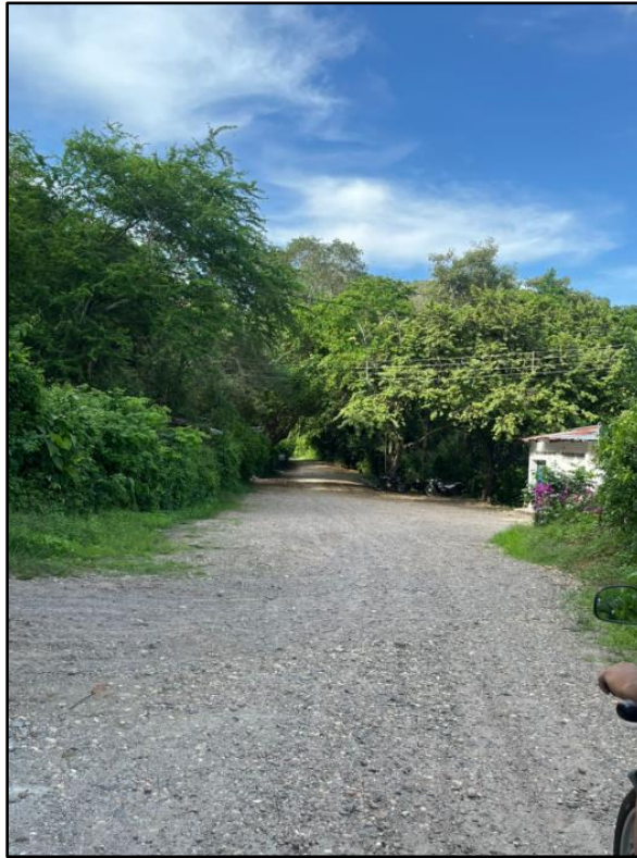
Figura 24 Terminación del tramo intervenido Fuente: Registro fotográfico propio.
