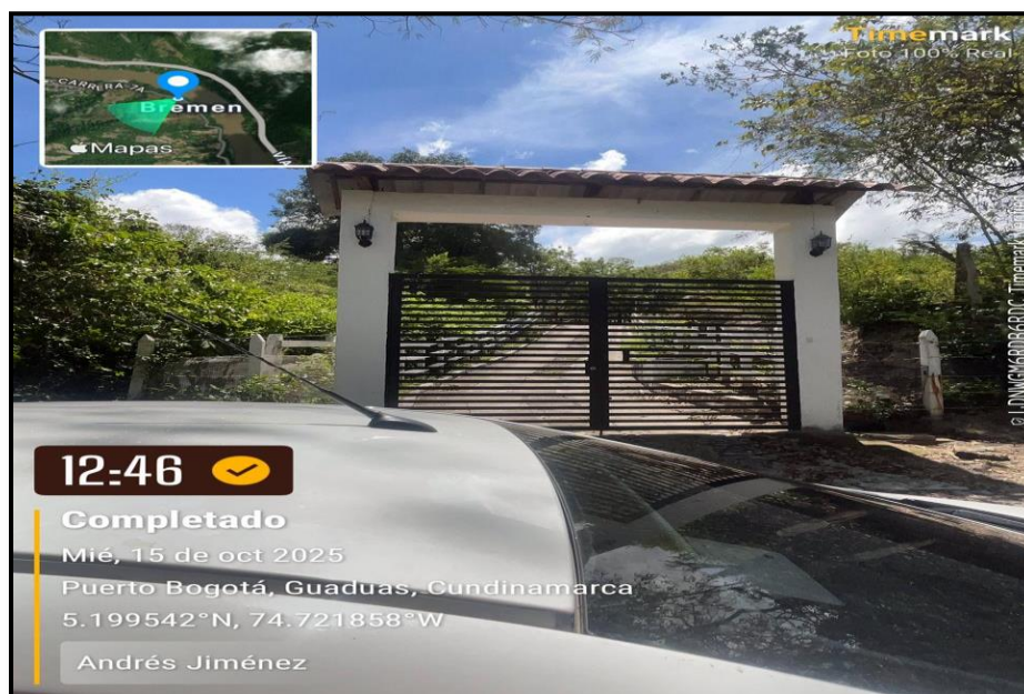
Figura 12 Predios ubicados a la orilla de la vía. Fuente: Registro fotográfico propio.
