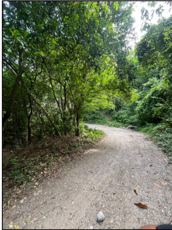
Figura 34 Curva pronunciada en el tramo a intervenir, es una de las más visibles
