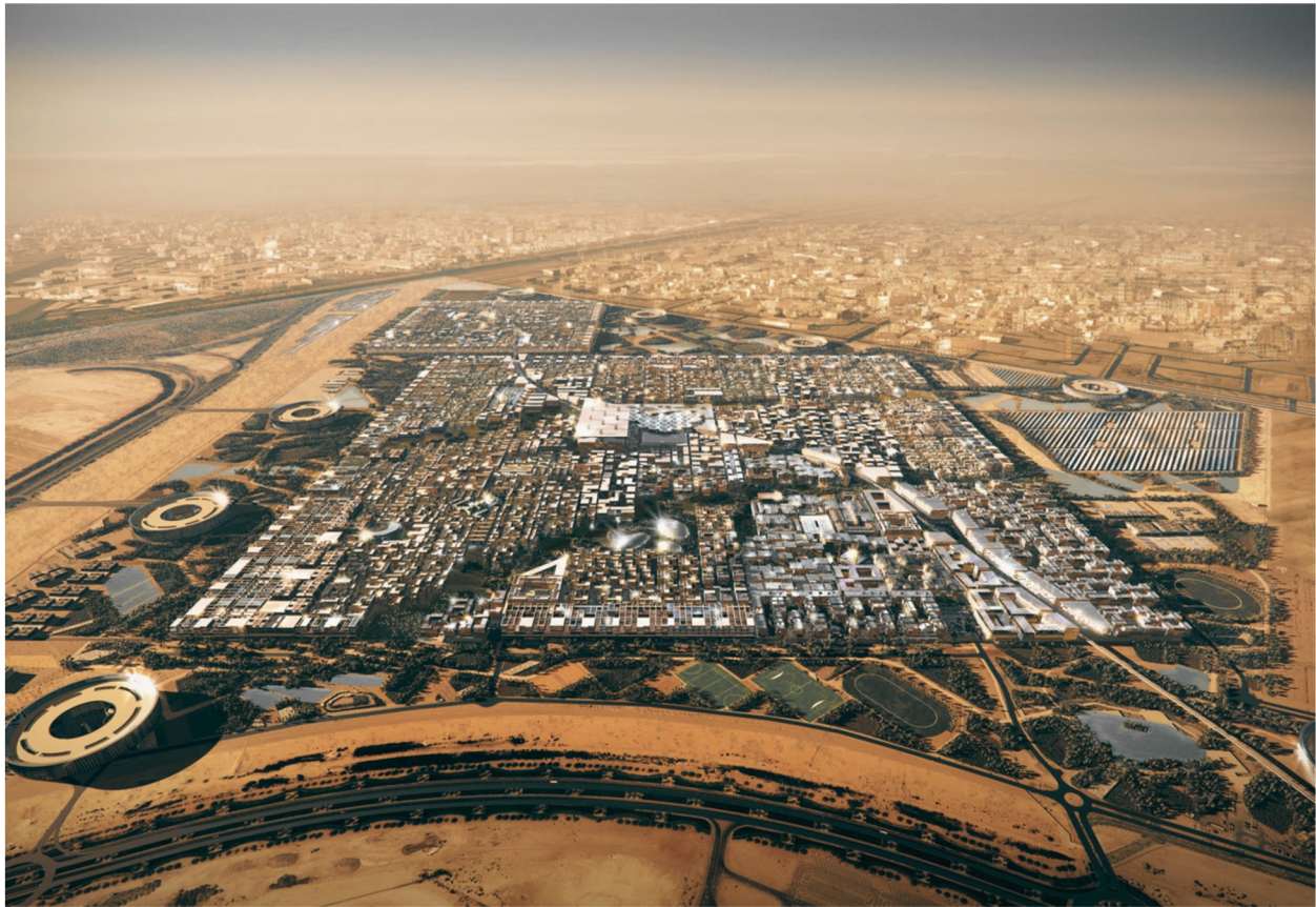
Vista Aérea del Proyecto.
