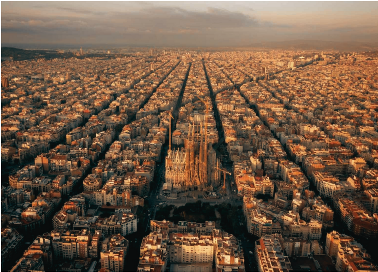
Vista Aérea del Proyecto.
