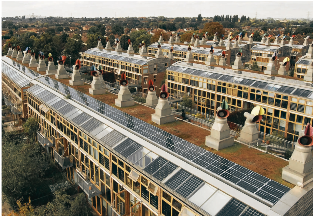
Vista Aérea del Proyecto.
