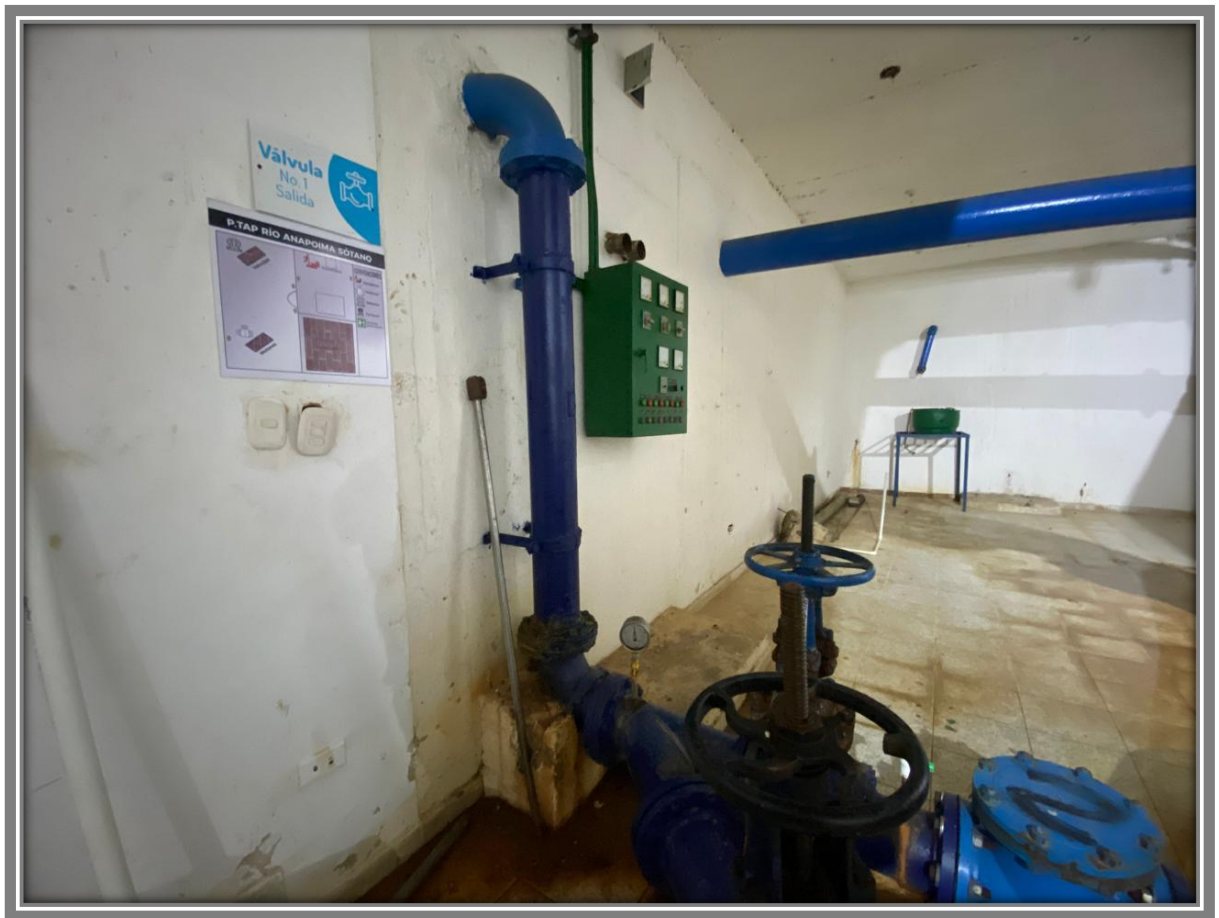
Ilustración 42 Válvula de salida No 1
