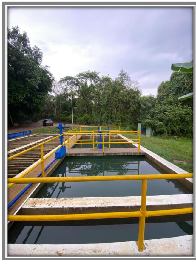
Ilustración 38 Sedimentador.
