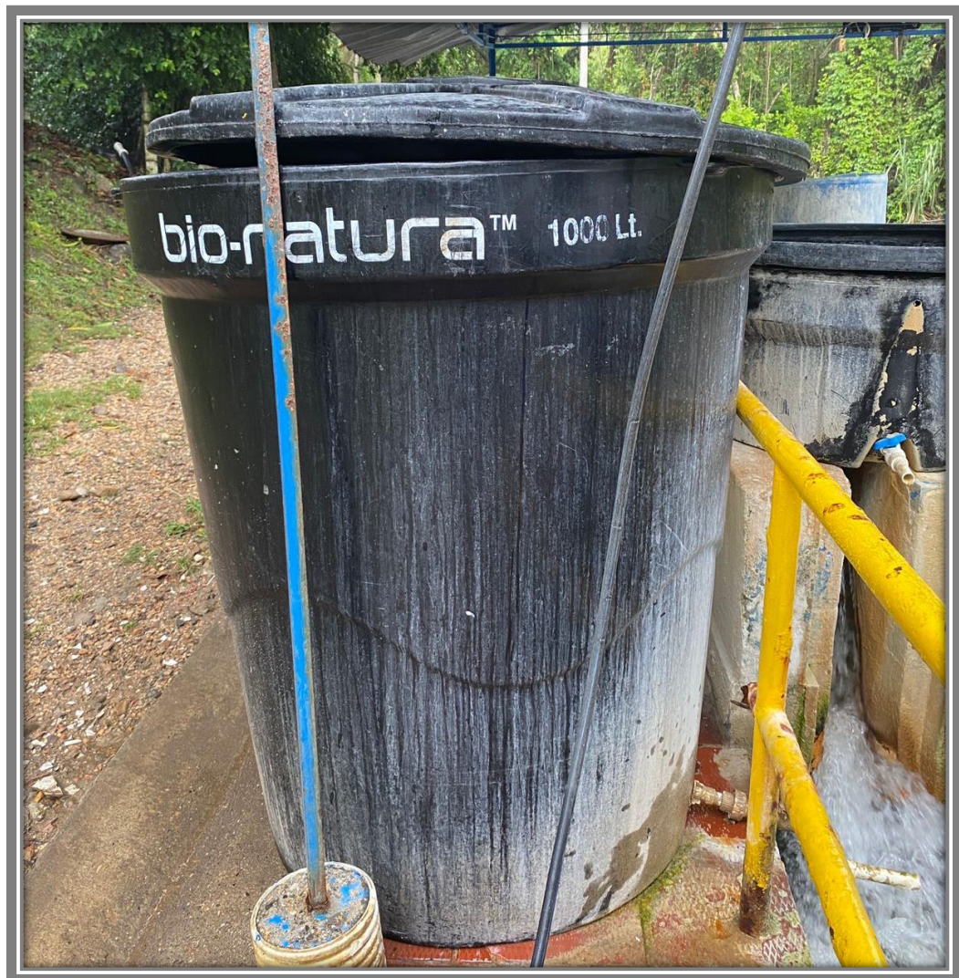
Ilustración 31 Tanque de 1000L para disolver el polímero Hidroxiclورو de aluminio
