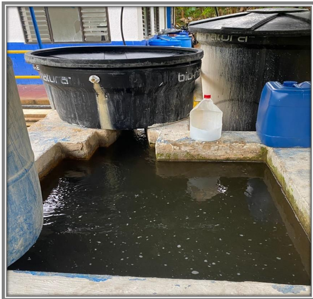
Ilustración 28 Cámara de entrada.
