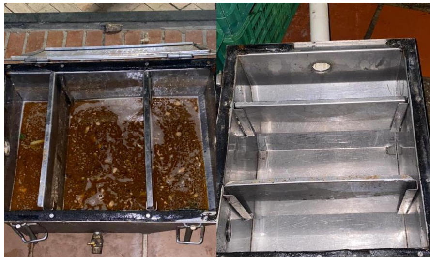
Figura 36 Limpieza en trampas de grasa de área de alimentos
