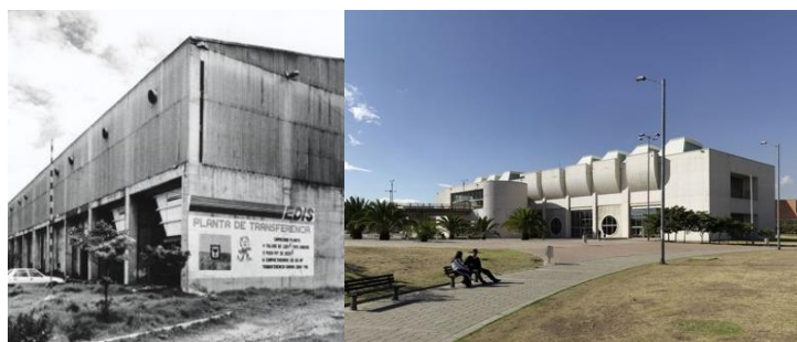
Ilustración 3 Antigua planta de basuras del distrito/Biblioteca El Tintal
