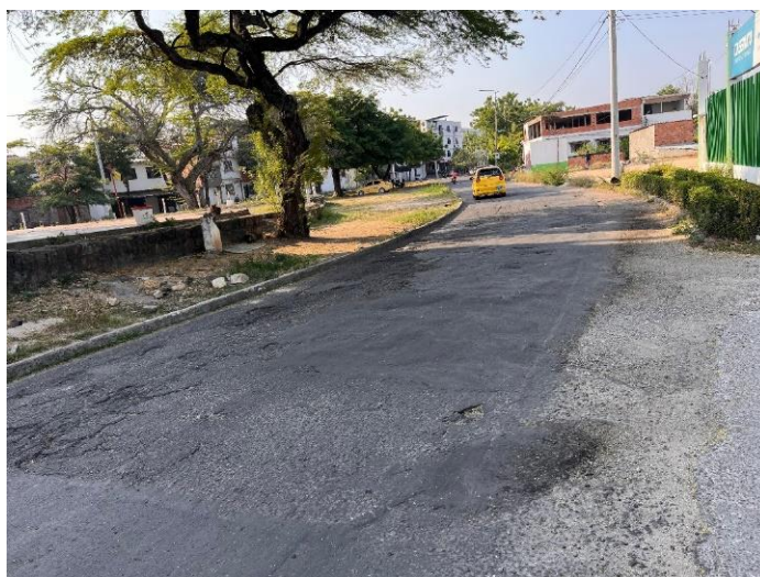
Figura 4. Evidencia fotográfica de la vía objeto de estudio
