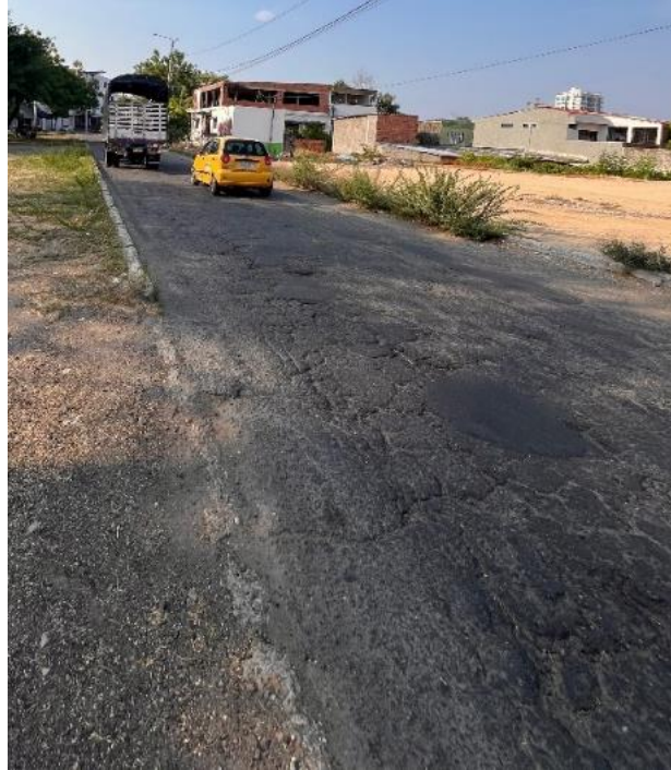
Figura 5. Registro Fotográfico del estado total de la vía objeto de estudio
