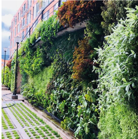
fig. 4 Muro verde en Bogotá recién instalado, tomado de: https://jardinesverticalesbogota.com/muro-verde-en-bogota/
