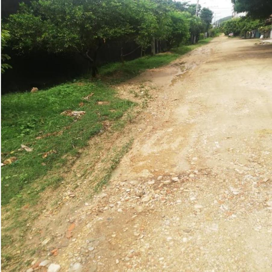
Fuente: zanjas causadas por el escarpe del terreno ya que no tiene alcantarillado de aguas lluvias.
