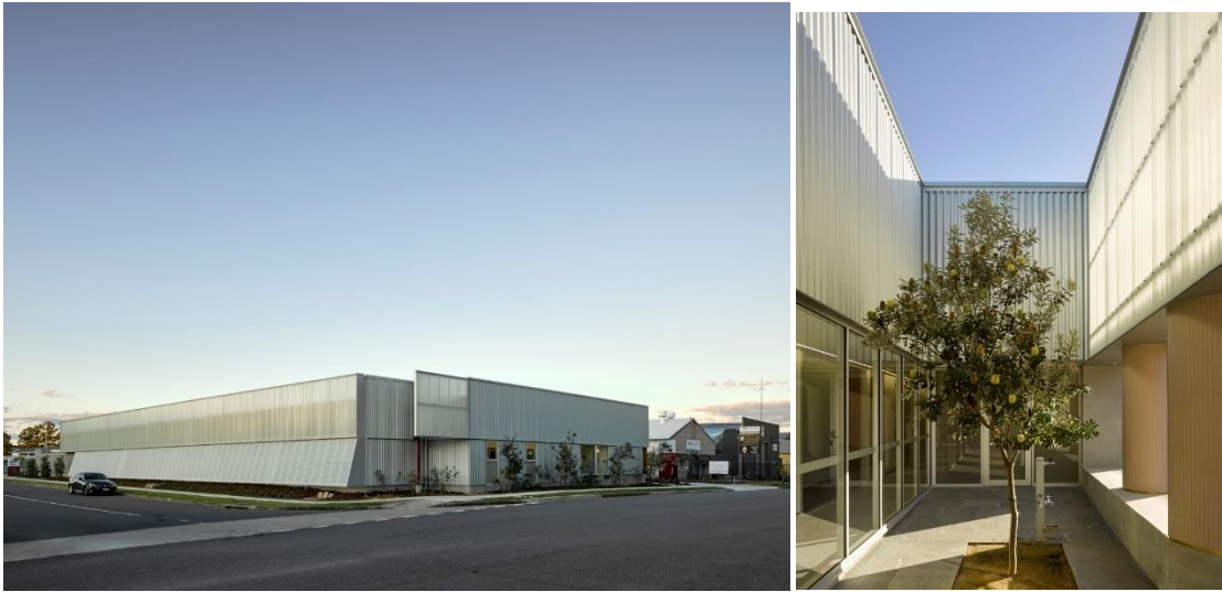
Ilustración 4. Hospital Veterinario Stafford / Vokes and Peters. Fuente: https://www.archdaily.co/co/1005935/hospital-veterinario-stafford-vokes-and-peters?ad_source=search&ad_medium=projects_tab
