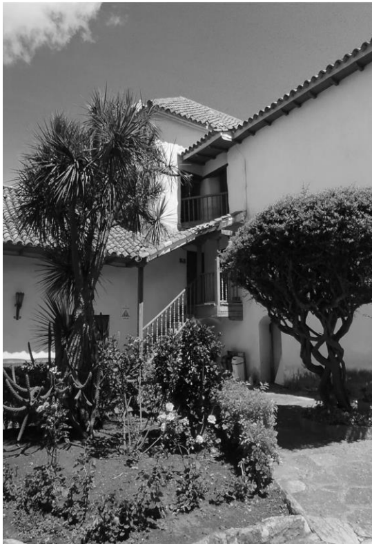
Figura 8. Casa del Escribano Don Juan de Vargas Fotografía tomada por mí misma.
