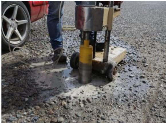
Figura 4. Extracción núcleo de concreto en losas afectadas de la central de Corabastos. Fuente: construcción propia.
