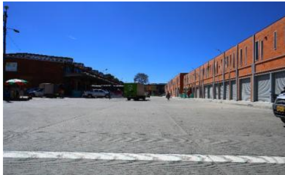
Figura 2. Losas de concreto en buen estado de la central de Corabastos.
