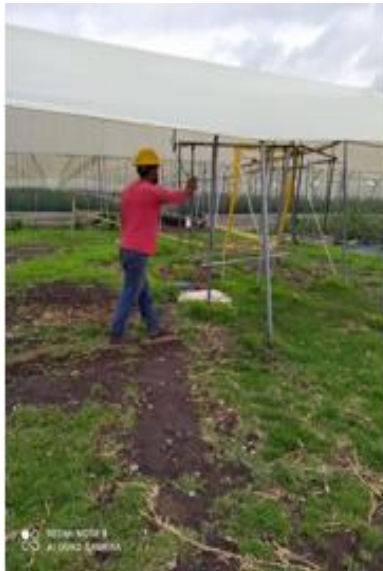
Figuras 8 y 9. Fotografías cable vía.
