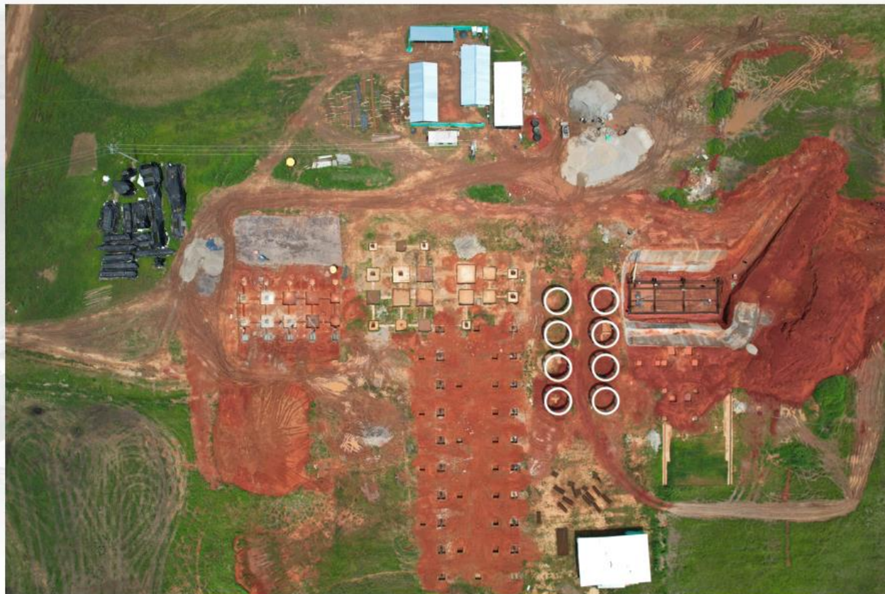
Avance obra civil planta de balanceado Barlovento
