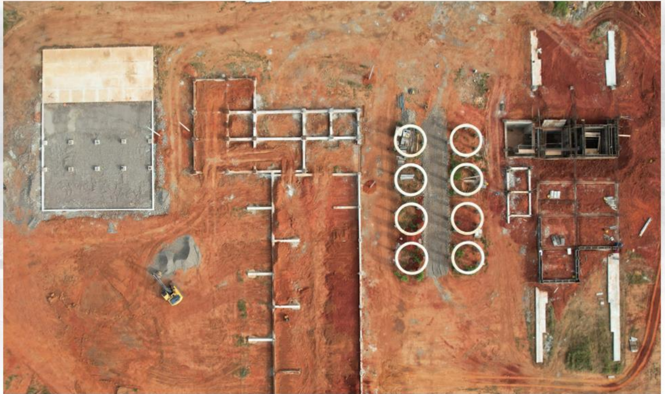
Avance obra civil planta de balanceado Barlovento
