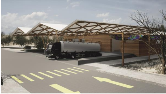
Figura 22 Cubierta plegada. Ilustración propia
