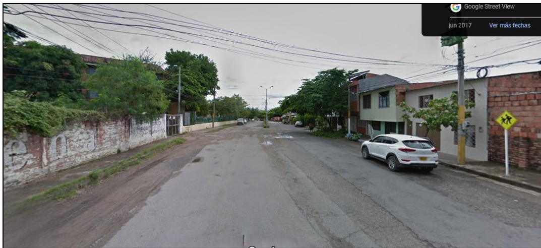
Imagen 28. Fotografía de la respectiva intersección de la calzada vehicular con andén derecho.
