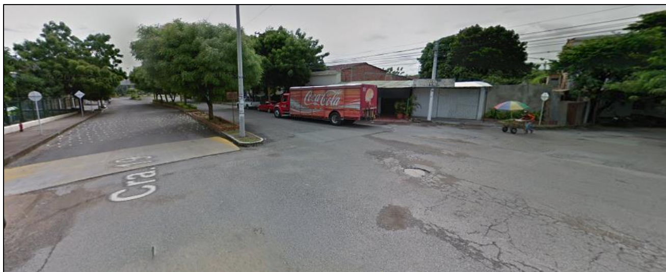
Imagen 36. Fotografía de la respectiva intersección del cruce seguro UDEC / Calzada vehicular con anden sentido derecho
