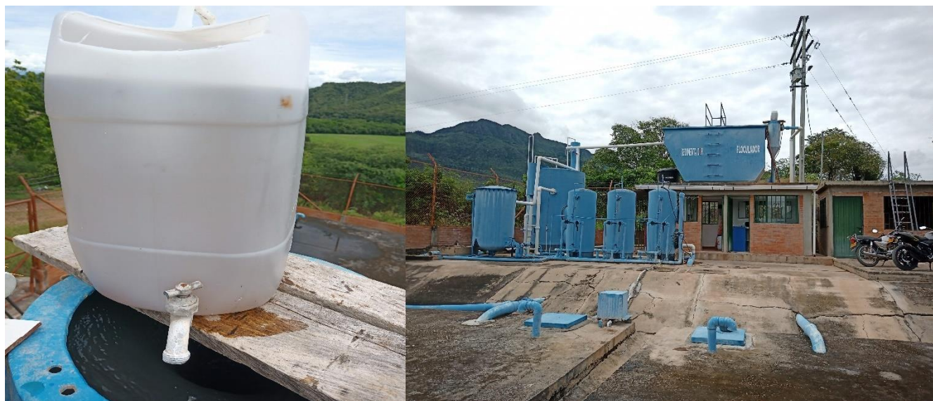
Figura 29. Aplicación manual de coagulante Autoría propia
