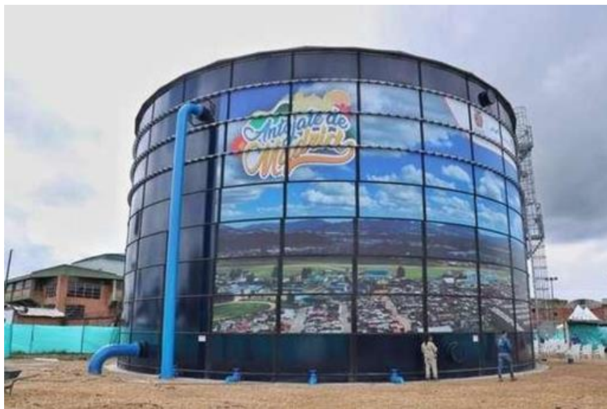
Figura 9: Tanque de almacenamiento empresa de acueducto. Fuente: elespectador.com/bogota/cundinamarca-madrid-ya-cuenta-con-uno-de-los-tanques-de-almacenamiento-de-agua-mas-grande-del-pais/
