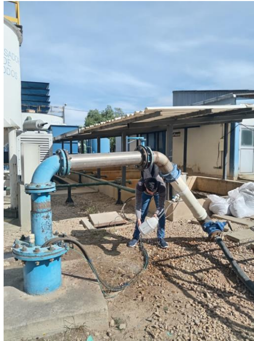
Figura 8: Pozo "8" Acueducto de Madrid. Fuente: Autoría Propia
