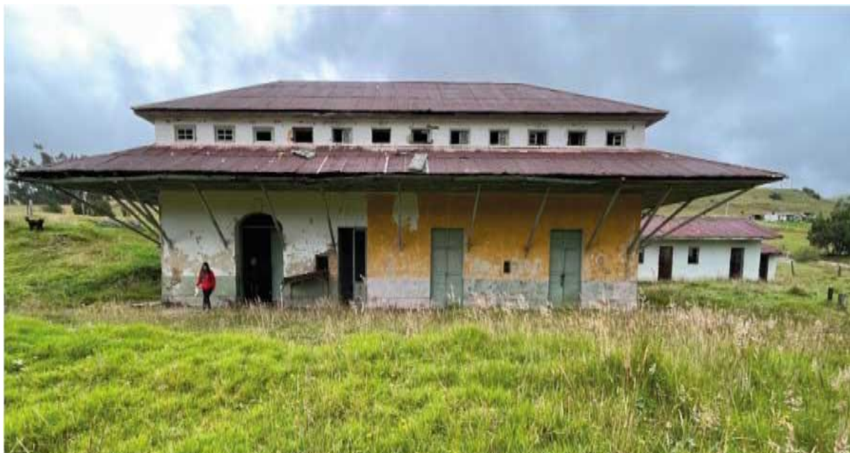
Figura 7 Infraestructura estación de tren “La Laguna”
