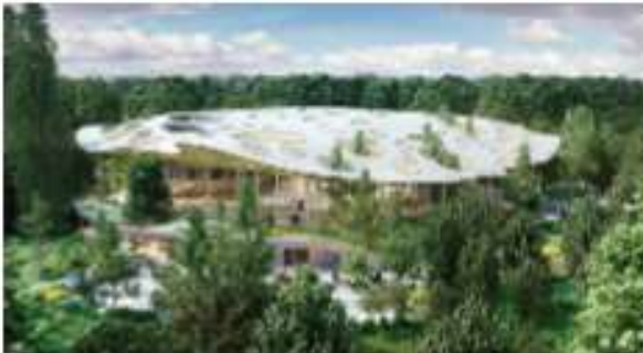
Vista de cubierta
