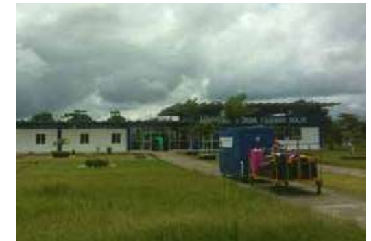
Aeropuerto de Guapí - Fuente propia
