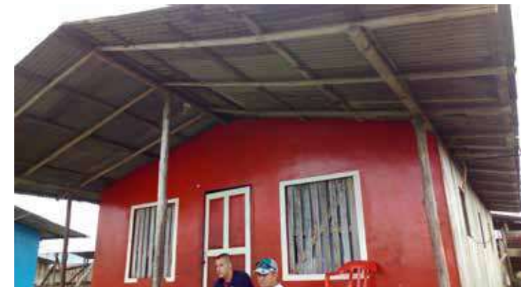
Cubiertas en Laminas de zinc
