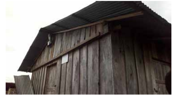
Fachadas en tablas de madera
