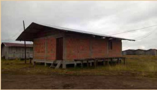
Fachadas en mamposteria
