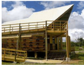
Ilustración 8. Acceso y cubiertas del Centro de capacitación indígena Kapaclajui.
