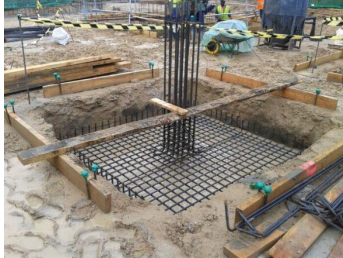
Imagen 2. Zapatas de edificaciones
