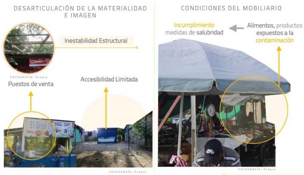
Figura 3. Problemáticas de infraestructura. Fuente: Elaboración propia. Fecha 13/02/22
