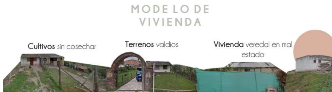
Imagen 16, Perfil existente en la Vereda de Fagua, Calle 6. (Elaboración propia).
