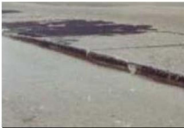
Figura 13. Escalonamiento de juntas.
