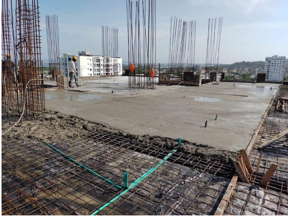
Ilustración 9: Visita a obra
