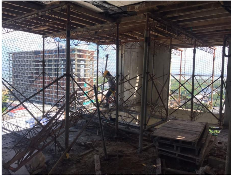
Ilustración 7: Visita a obra
